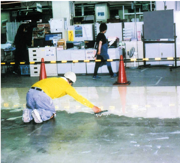
オフィスビル床改修
